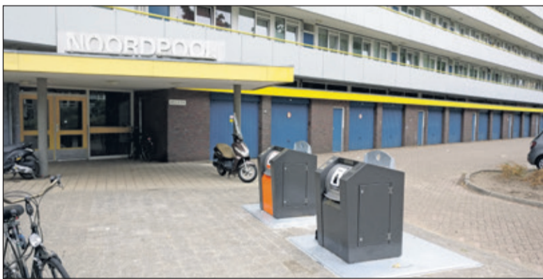
Een volle container gaat automatisch op slot. Restafval kan niet naar de gemeentewerf.
