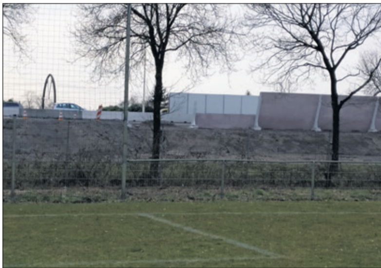
Op deze foto van 23 maart, genomen op de sportvelden van SVM, zijn van oost naar west de laatste werkzaamheden zichtbaar aan het nieuwe geluidscherm en daarvoor het tijdelijke geluidsscherm, geplaatst op een betonnen barrier.
