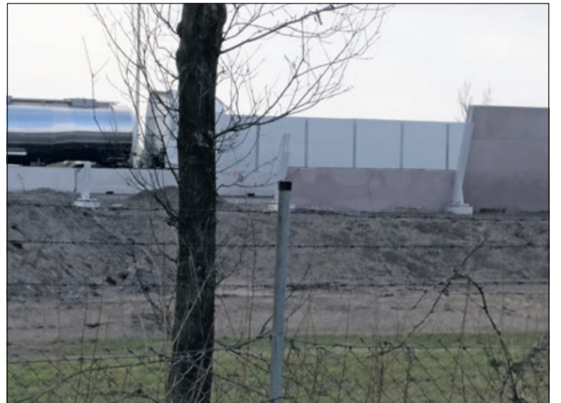
Op deze foto van RWS (jan. 2018) zijn aan de westzijde twee gedeeltes van de definitieve schermen zichtbaar (rood/bruine kleur), naast nog veel tijdelijke schermen (wit). Op veel plekken (met name aan de oostkant) is dan nog niets definitiefs gerealiseerd. De ruimte tussen de tijdelijke en (straks) definitieve schermen heeft ook voor de werkzaamheden een veiligheidsinvloed.
