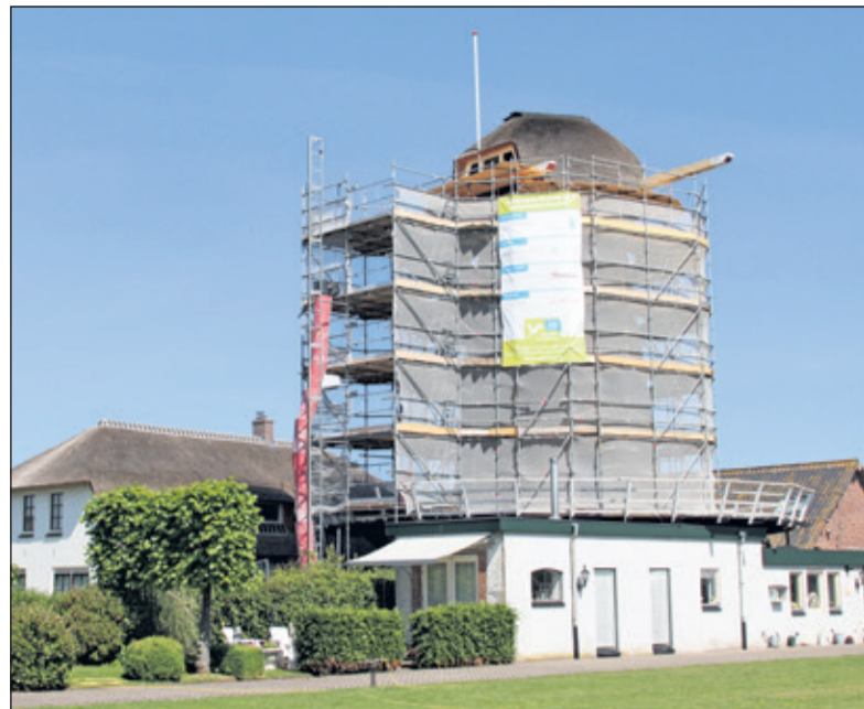
Voor korenmolen Geesina werd het afgelopen jaar gedomineerd door de restauratie ervan en alles wat daar aan vast zat.
