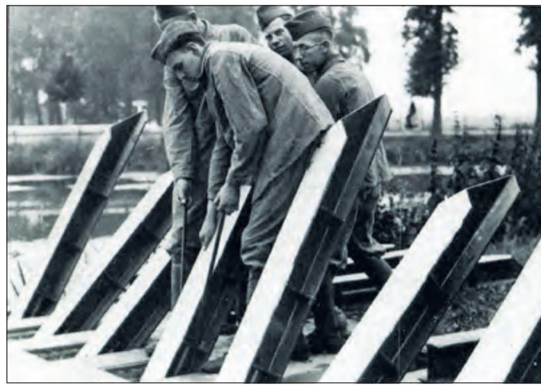
Oefening in het plaatsen van I-balken van de tankversperring in de Singelweg ten noordoosten van Fort Blauwkapel in 1939. (foto van D.G.W.T. Utrecht)
