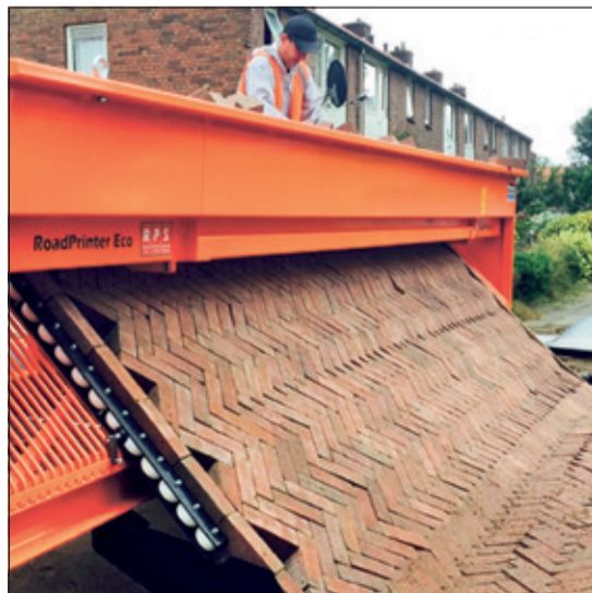
Aan de bovenzijde van de machine wordt het stenen tapijt met mankracht 'geweven'.
