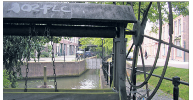
De valschut in de Oosterstroom.
