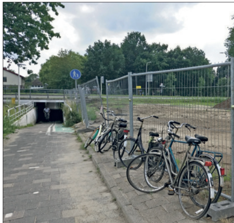
De voorbereidingen zijn afgerond; het oude tunneltje wordt nog gebruikt. [foto Henk van de Bunt]
