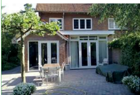
Renovatie en uitbouw
