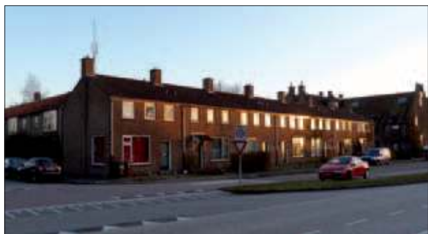
De (voormalige) gemeentewoningen aan Industrieweg en de Tolakkerweg.
