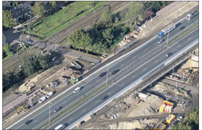
Het viaduct over de Dorpsweg in Maartensdijk wordt zowel aan de oost- als westzijde met 6,6 meter verbreed.
