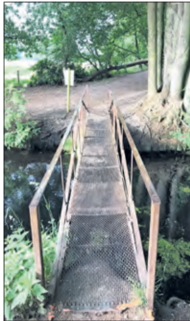
Een laatste foto van voor de restauratie.
