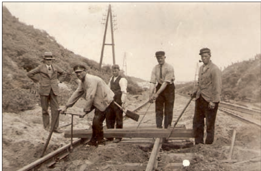
De baanwerkers Weening, Gasenbeek, Gram en Van der Linden met links de chef in 1930 bezig aan de spoorweg in Hollandsche Rading.
