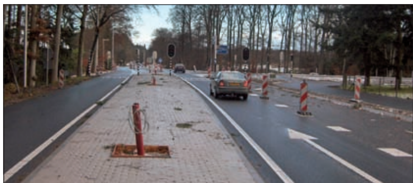
De Rotonde in de N234 waar de afslag is naar Den Dolder, de Nieuwe Dolderseweg (N238), wordt ook al vervangen door verkeerslichten.
