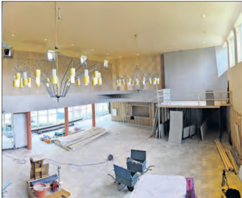
Van buiten blijft het gebouw zoals het is, maar het interieur ondergaat een complete gedaanteverandering. (foto Nico van den Ham)
