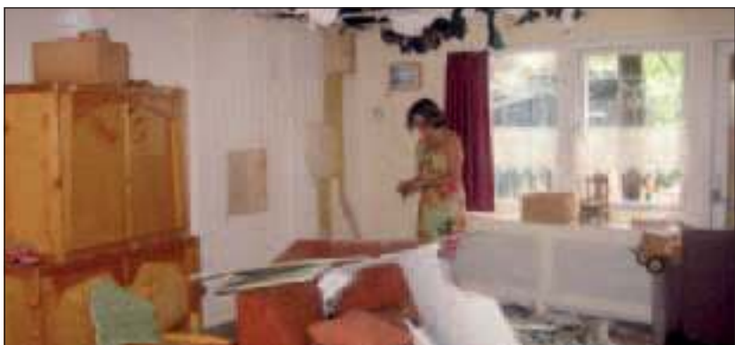
De ravage in het lokaal van de Rudolf Steinerschool.
