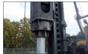
Een van de laatste palen wordt de grond ingeheid.
