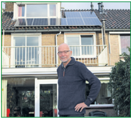
Aad: “Met deze zonnepanelen wekken we 1750 kilowatt op van de 2000 die we jaarlijks verbruiken (foto: Jenny Senhorst).”
