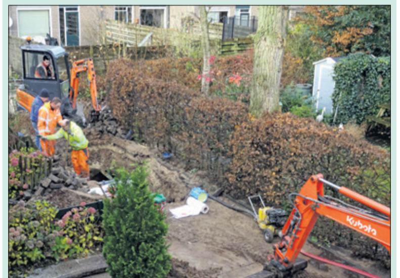
Reparatiewerkzaamheden aan de Bereklaauw in Maartensdijk.
