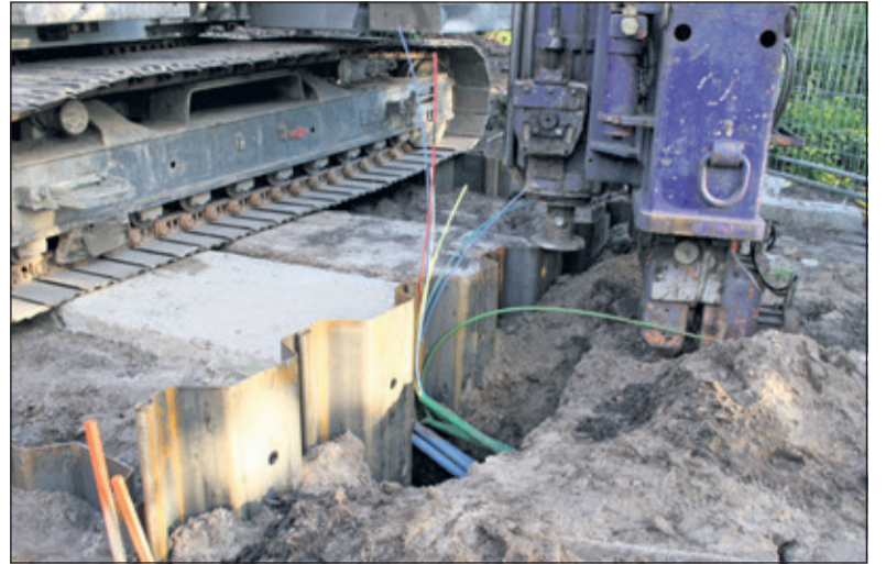
Bij het plaatsen van een damwand werden de glasvezelkabels van Ziggo en KPN doorgesneden en zaten veel inwoners een dag zonder internet, televisie en telefoon.
