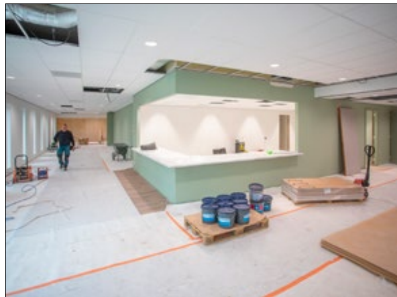
■ De keuken in aanbouw.
