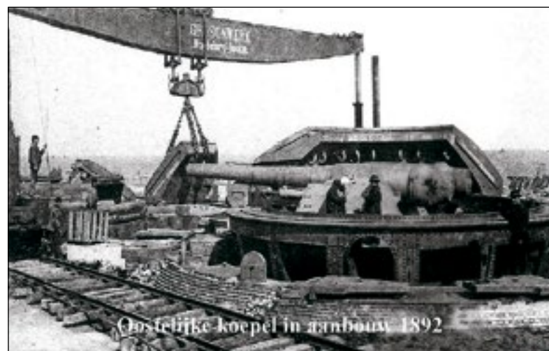
De oostelijke koepel in aanbouw.
