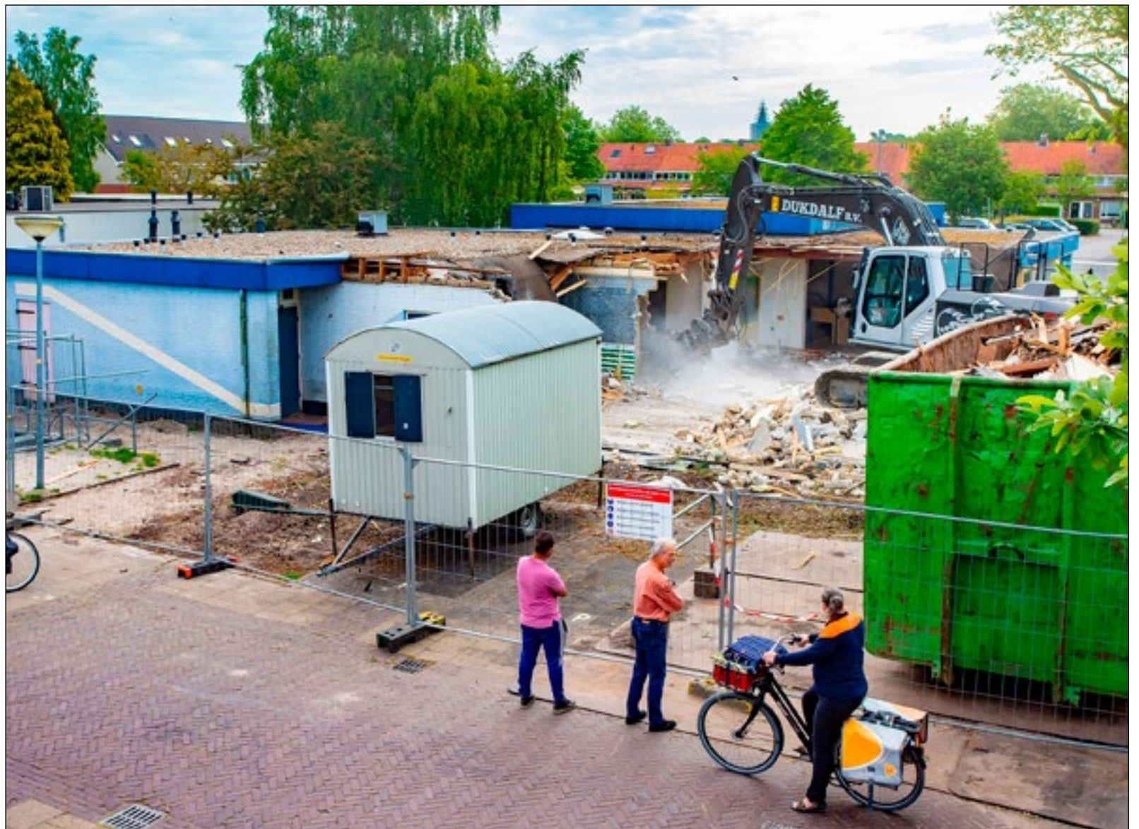
Dinsdag waren de sloopwerkzaamheden volop bezig.
