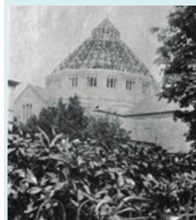
De kerk in aanbouw (1920) (bron: archief gemeente Gooise Meren)
