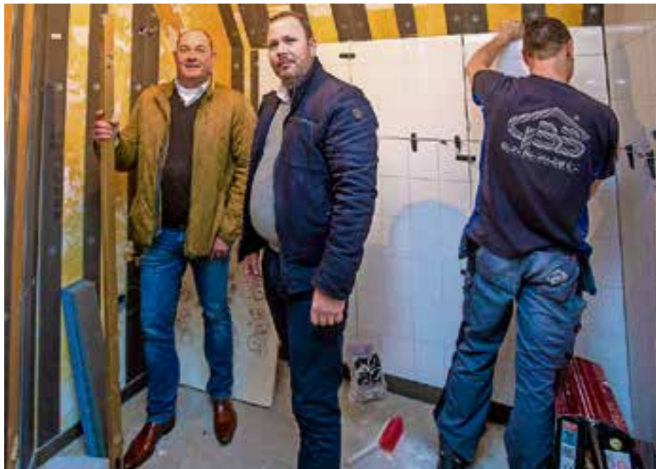
Alex Hagen en Sander Mulder bij het renovatieproject.
