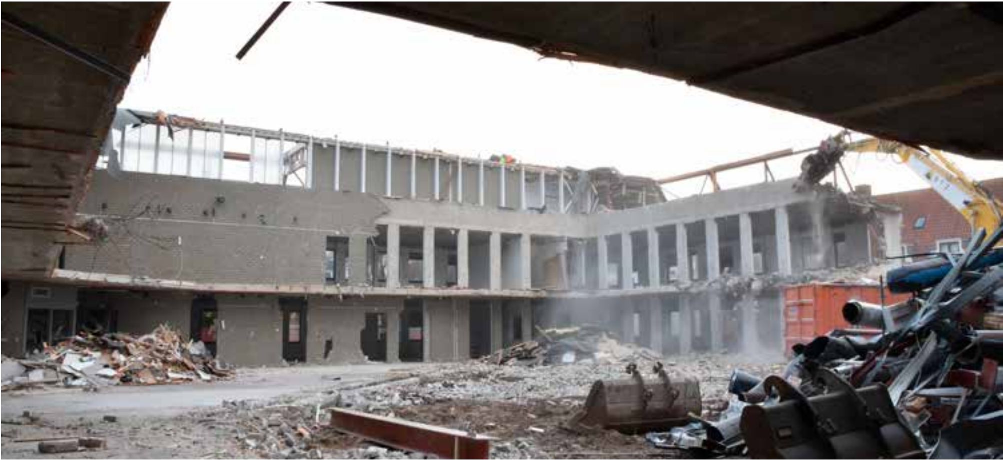
■ Als eerste werd de binnenkant gesloopt.
