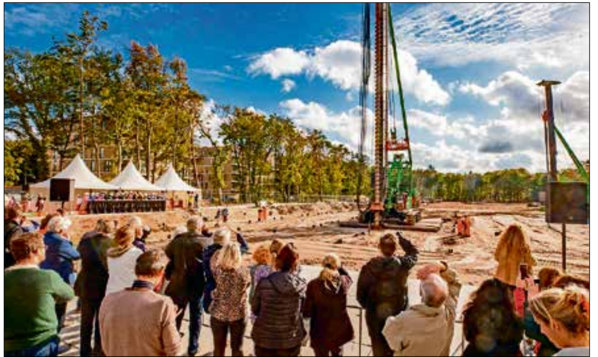
De eerste gaten werden in de grond geboord.
