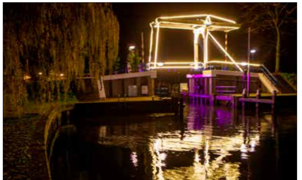
■ December: de brug over de aanloophaven wordt voor het eerst verlicht.
