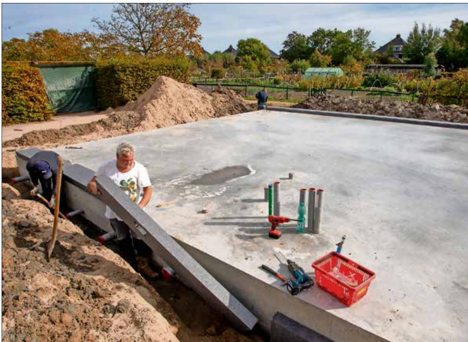
■ Het fundament is gelegd.
