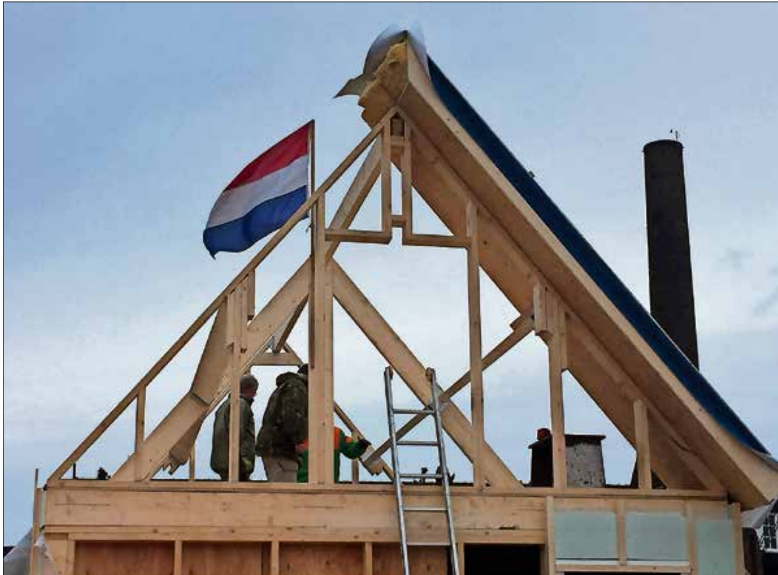
■ Het nieuwe havenkantoor in aanbouw.
