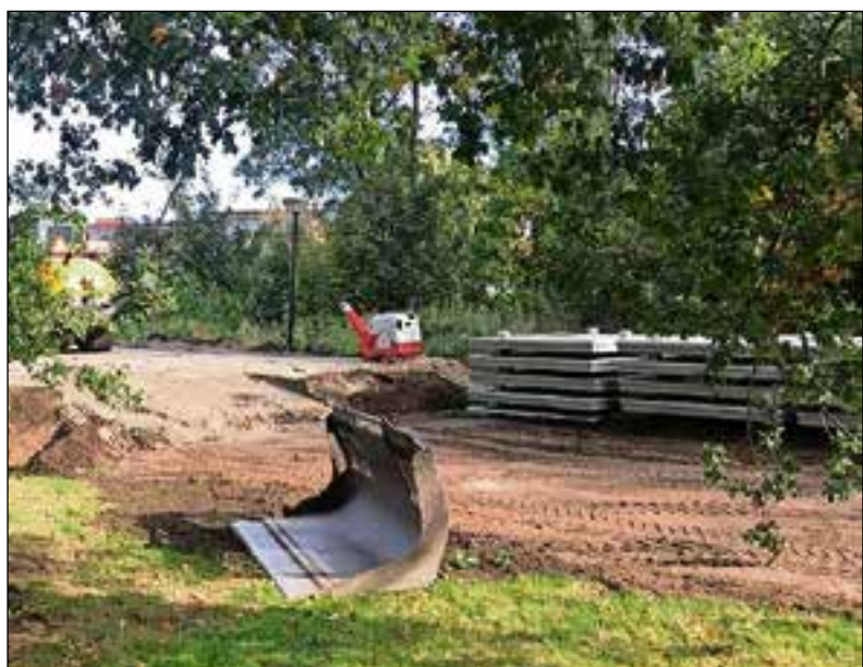
■ Het terrein wordt al illegaal klaargemaakt voor het paviljoen.
