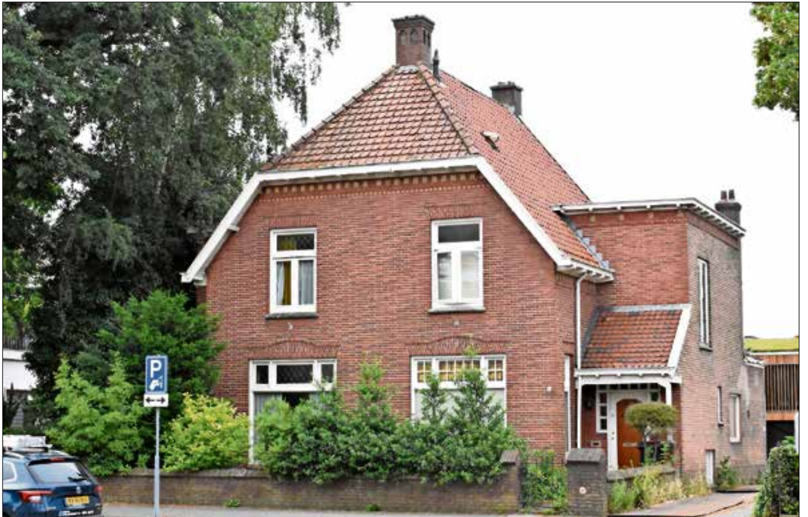
Dit dubbele woonhuis moet wijken voor een nieuw kantoorpand.
