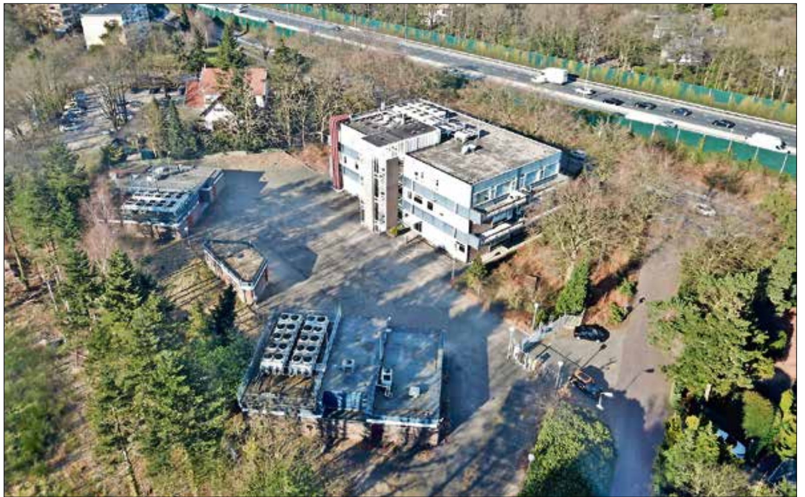
■ Het kantoorpand heeft drie verdiepingen en een grote parkeerplaats.
