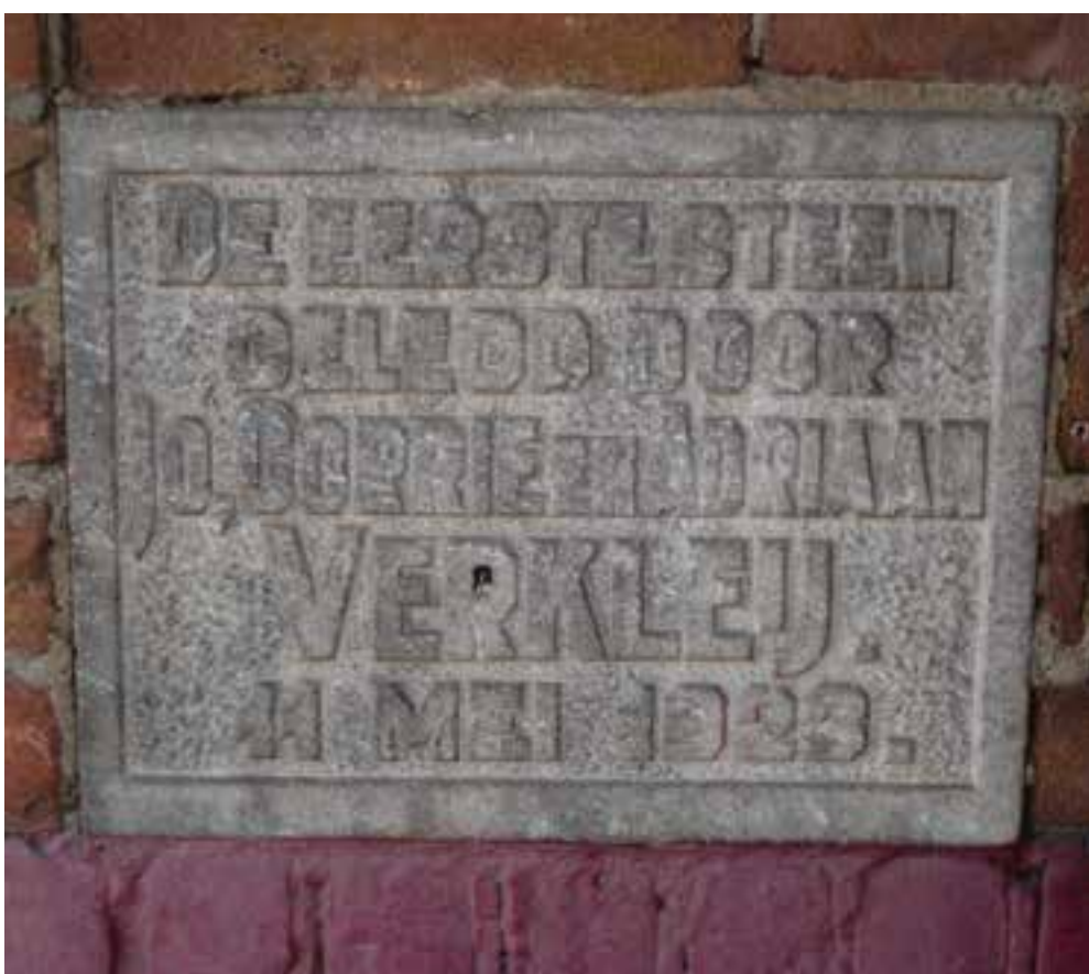
Herinnering pand Huizerweg 39 van de eerste steenlegging 1923 door Joop Corrie en Adriaan Verkleij
