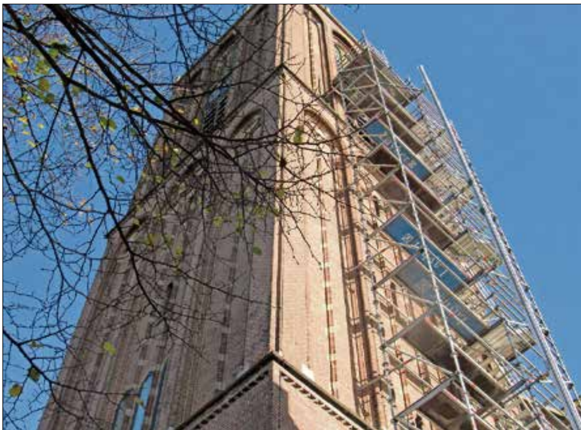
■ Een enorme stelling is tegen de 60 meter hoge kerktoeren geplaatst.
