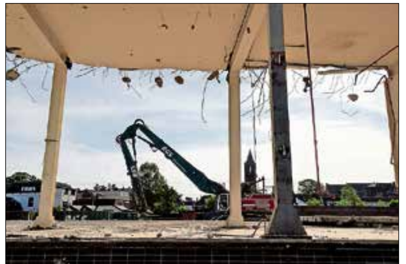
De laatste sloopwerkzaamheden.
