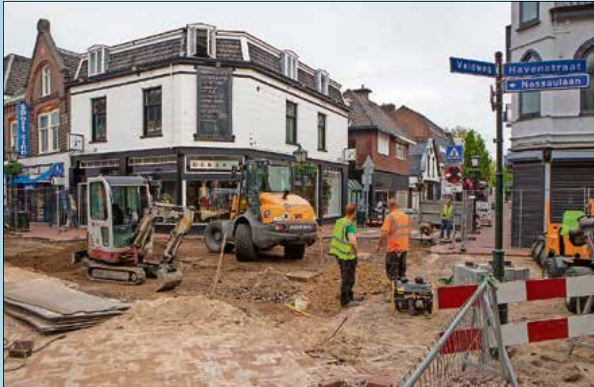
Er wordt volop gewerkt aan de nieuwe kruising.
