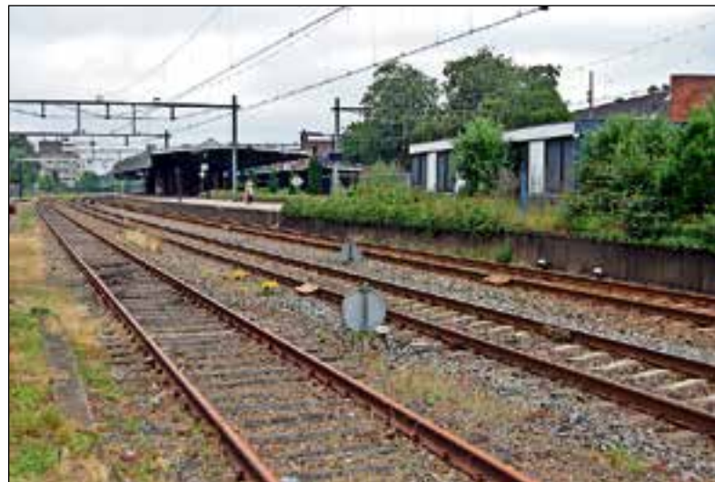
Er komt een entree aan de achterkant.
