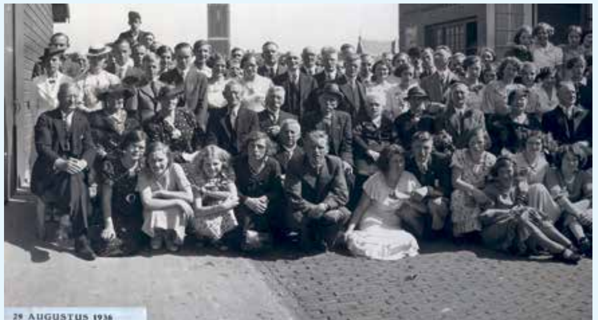
Groepsfoto uit 1936 met op de hoek rechtsachter de in het directiegebouwtje ingemetselde steen.
