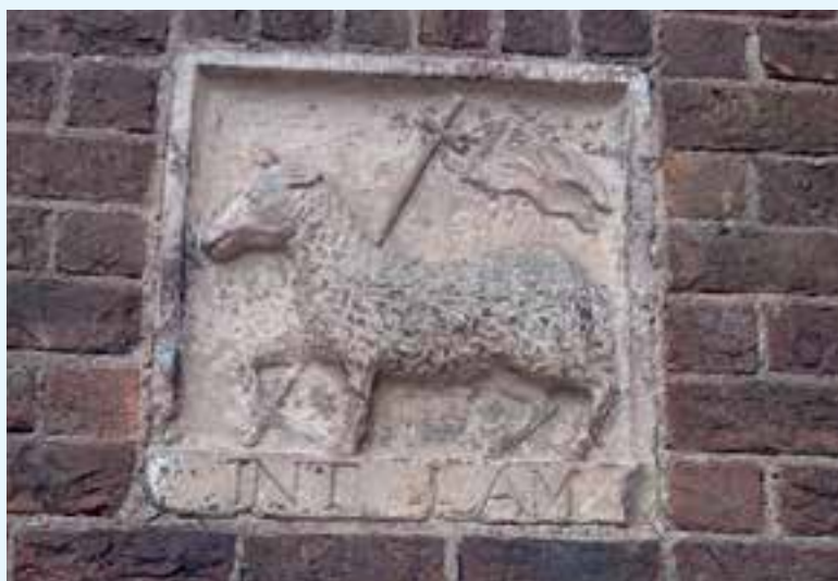
De gevelsteen vóór de uitname in december 2016.
