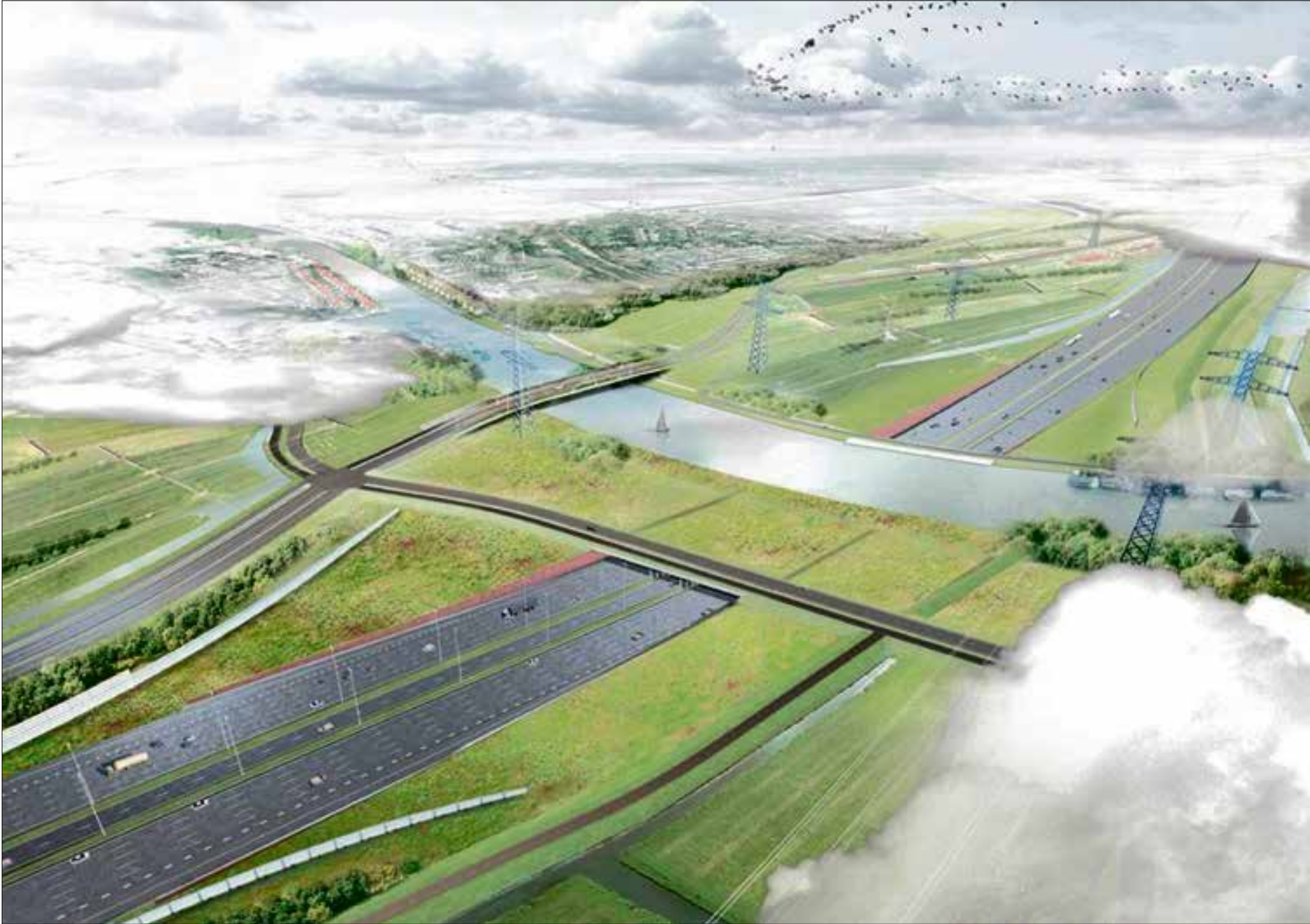
Impressie van het nieuwe aquaduct met twaalf rijbanen. In de spits zijn zeven banen tegelijkertijd één kant op open.
