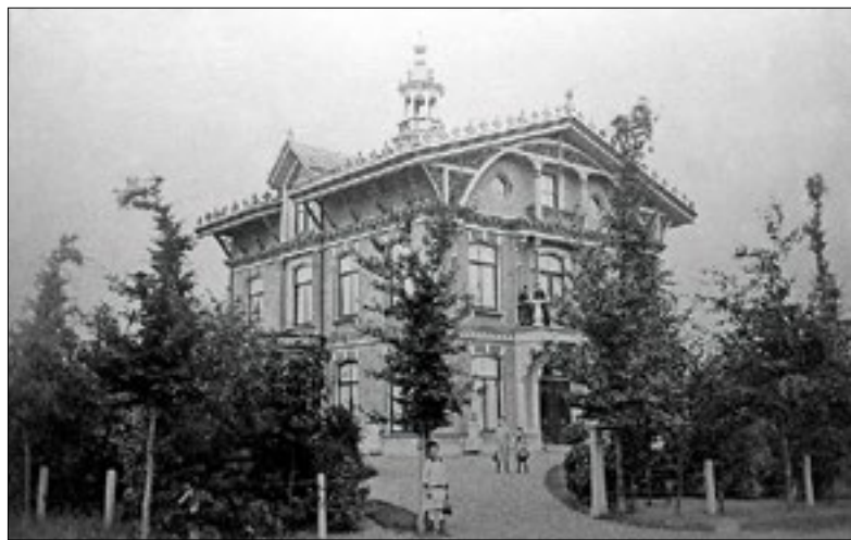
■ De villa Nieuwburg rond 1900.
