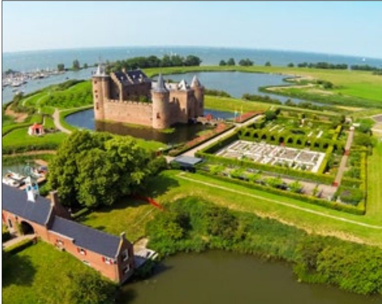
■ Het Muiderslot is onderdeel van de Nieuwe Hollandse Waterlinie.
