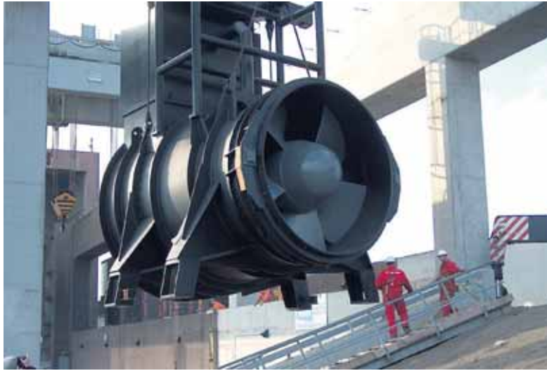
In 2004 plaatste Pentair Fairbank Nijhuis twee pompen met elk een capaciteit van 60.000 liter per seconde voor gemaal IJmuiden. Dit leverde een vermelding op in het Guinness Book of Records. Foto: PR
